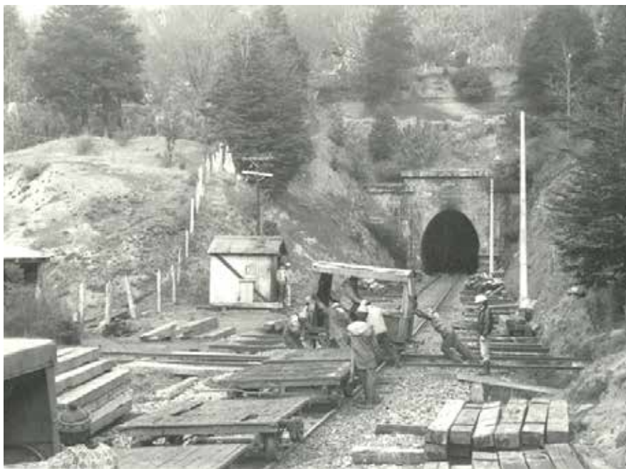
Fotografía de la construcción del túnel Las Raíces, boca norte Curacautín
