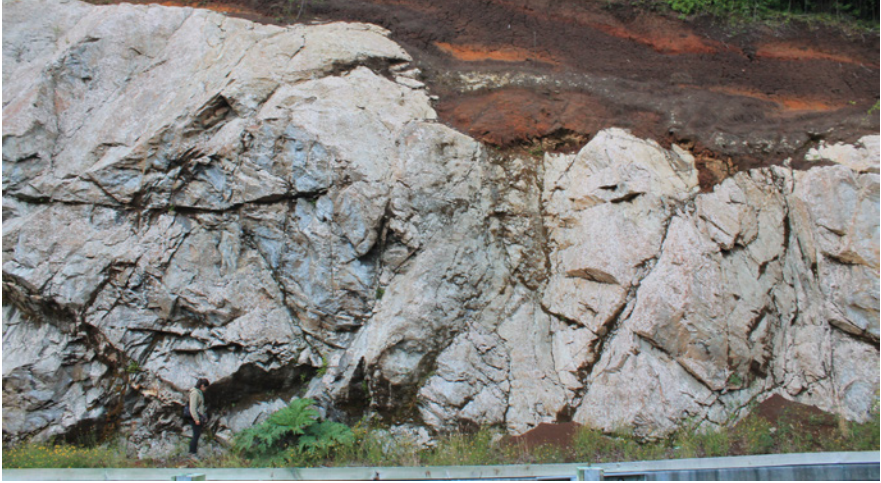
Desarrollo de suelo en corte de camino ruta 7 El Amarillo-Puerto Cárdenas
