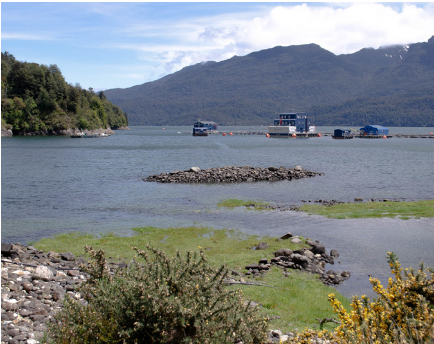
Desechos industriales (arriba) e infraestructura (abajo) asociados a la salmonicultura
